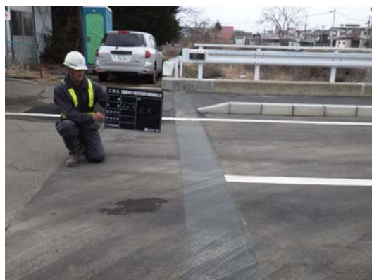
写真4-2 【対策】 伸縮装置の交換、橋面防水、舗装
