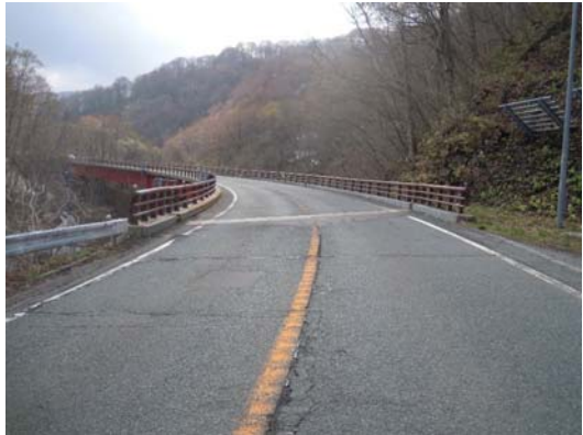
写真4-6 【全景】下竜川橋
