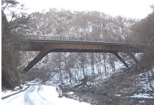
写真4-17 【対策】 地覆補修、高欄取替、桁塗替塗装
