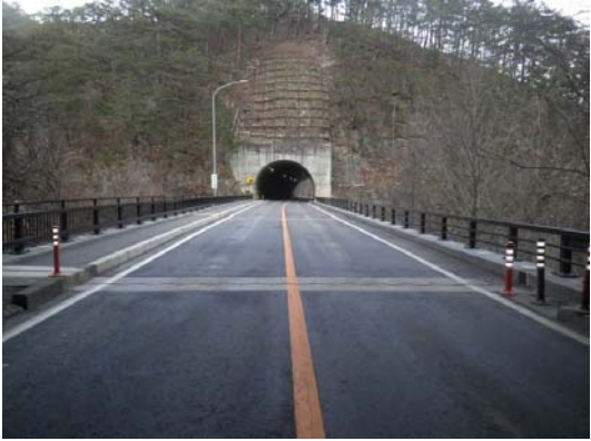
写真4-15 【全景】達曽部橋
