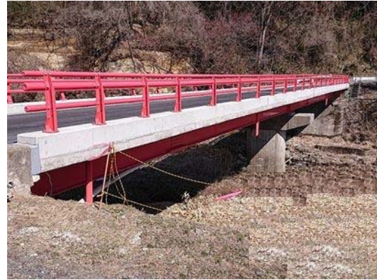
写真4-19 【対策】 地覆補修、高欄取替、桁塗替塗装
