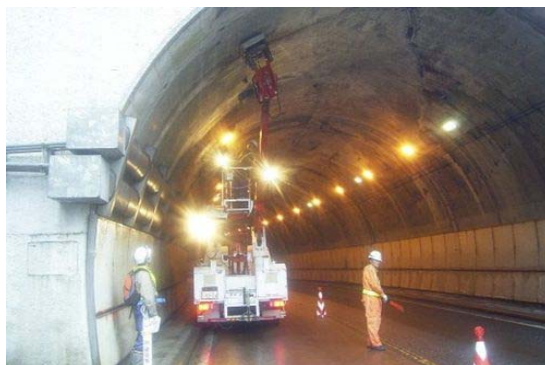
写真3-2 トンネル点検状況
