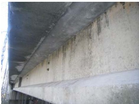
写真4-11 【対策】 鉄筋防錆処理・断面修復・含浸材塗布
