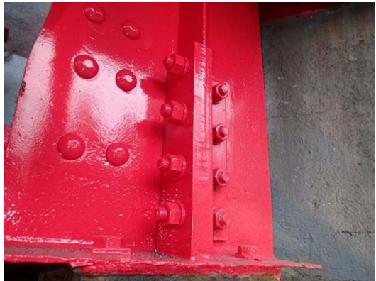
写真4-8 【対策】主桁端部交換
