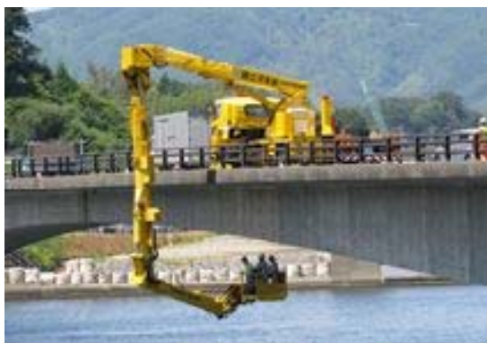
写真3-1 橋梁点検状況
