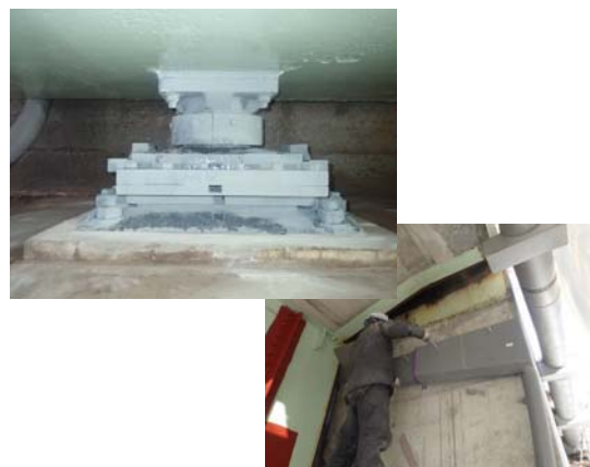
写真4-5 【対策】 支承補修、簡易排水樋設置
